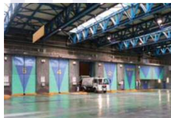
1 プラットホーム
