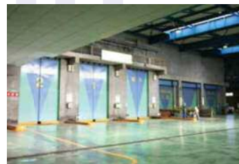
1 プラットホーム
